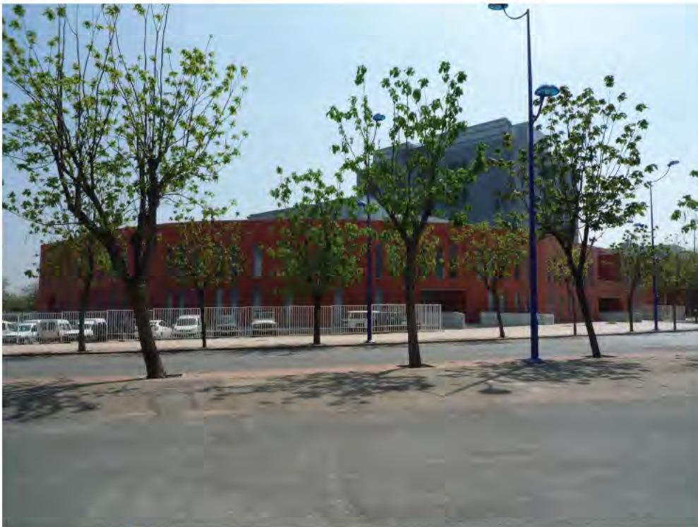
Het gebouw van het Instituto de Microelectrónica de Sevilla
